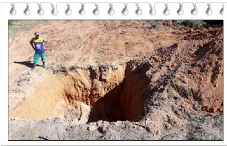
A escavação para o Tanque de Fermentação necessita de 2,70 m de profundidade e 3,70 m de circunferência.
