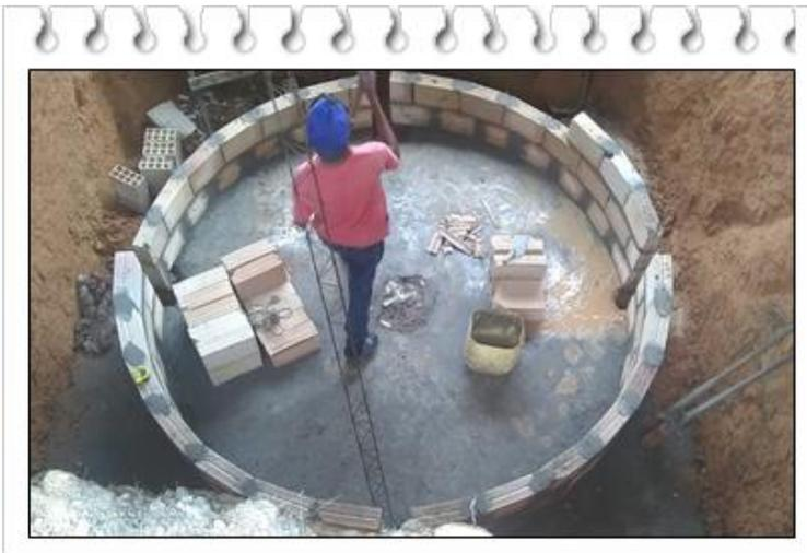
Após regularização e apiloamento do fundo da vala, foi feito um piso de concreto com armação de aço ("radier") montada com vergalhão de bitola 6.3mm, no formato
