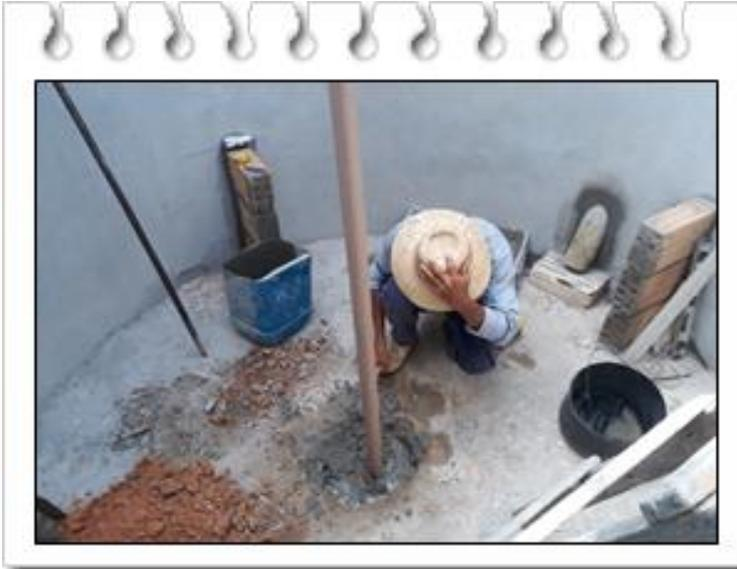
O cano guia é desenvolvido através de um eletroduto galvanizado Médio 1 1/4" de 40 mm de diâmetro com 4,3 m de comprimento fixado no centro da caixa de fermentação, para
