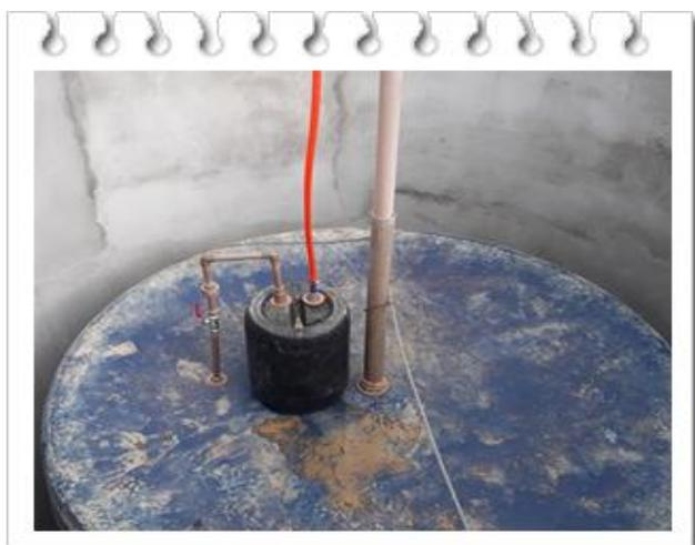
O flange de 60 mm deverá ser instalado com a rosca virada para fora da caixa, para permitir a instalação do cano guia por dentro. Ambos
