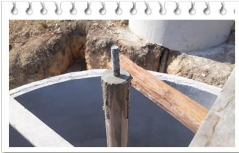
Na ponta, com a massa ainda fresca, foi colocado um parafuso francês 3/8 de diâmetro e 29 centímetros de comprimento no
