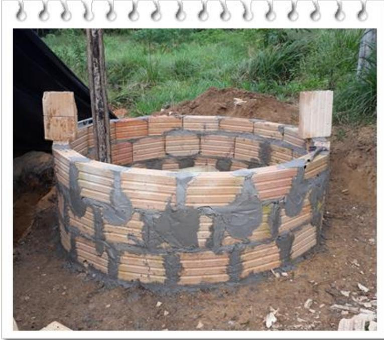
A Caixa de Carga foi construída em formato cilíndrico em alvenaria, após regularização e apiloamento do fundo da vala, foi realizado um piso de pedra argamassada com 1,20 metros de diâmetros, a parede da Caixa de
