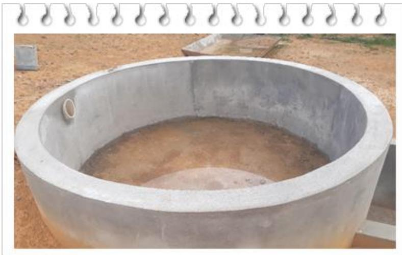
A parede finalizada ficou com 80 centímetros de profundidade até o piso acabado. Feito a ligação do primeiro compartimento com o Tanque com um cano
