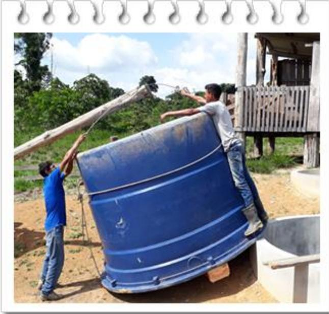
Para fazer a Câmara de Armazenamento do biogás, utilizou-se uma caixa de polietileno de 5000 litros, com uma furadeira elétrica e serra-copo abriu-se um furo medindo 76 milímetros de diâmetro no centro da caixa, colocando nele um flange de 60mm. É por esse furo que
