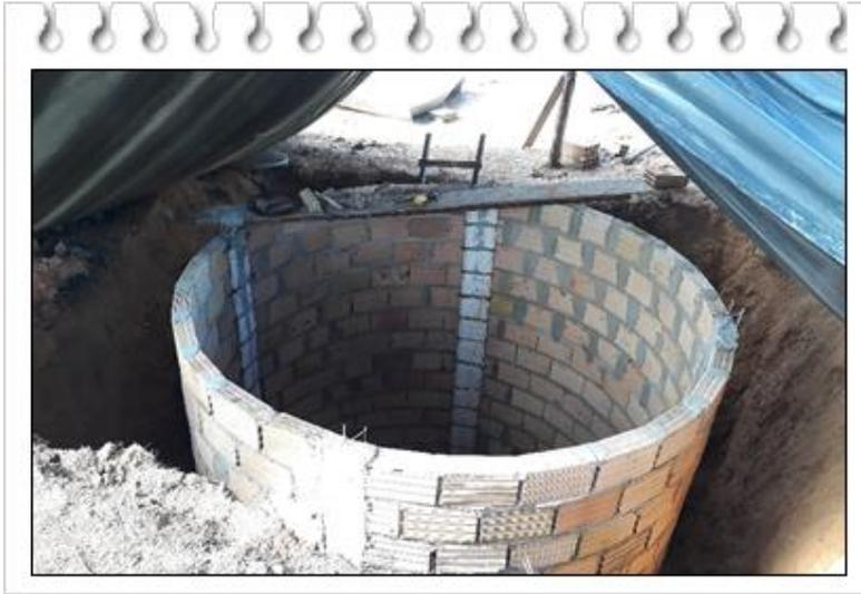
A parede do Tanque de Fermentação foi assentada com tijolo cerâmico furado 8 furos e 4 pilares de amarração e sustentação da estrutura, antes do reboco foi feito um
