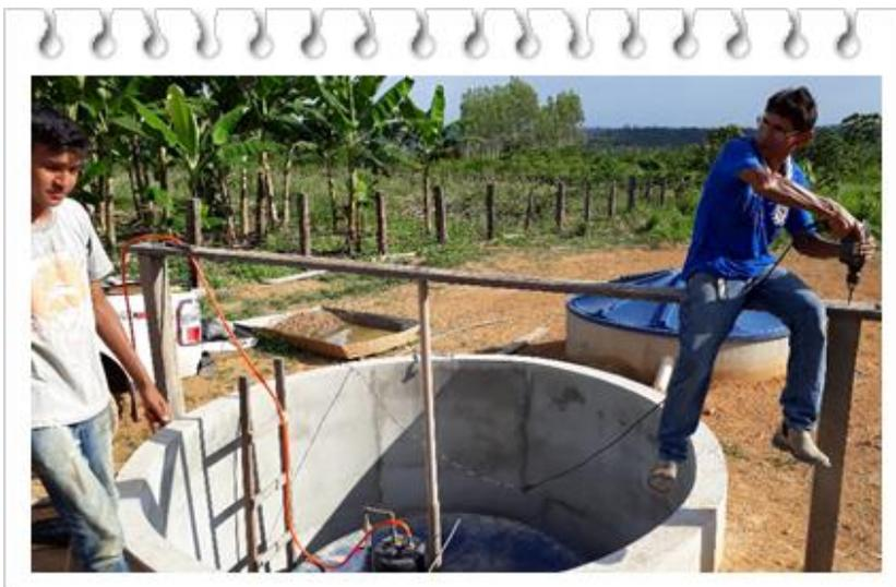
A trave de segurança montada com 03 peça de madeira retiradas da propriedade. Duas medindo 2,50 metros de comprimento e
