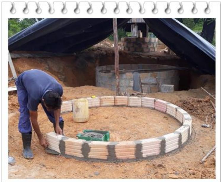
furado 8 furos com 2,40 metros de diâmetro e rebocada com argamassa cimento e areia traço de 3:1 (3 carros de mão de areia fina peneirada: 1 saco de cimento).
