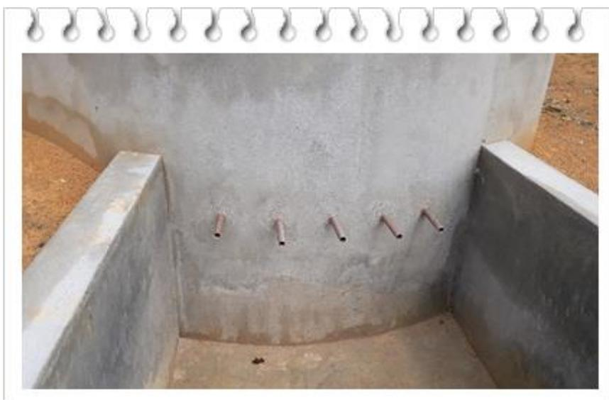
divisões. Colocou-se telas nestes tubos de passagem para facilitar o processo de limpeza dos reservatórios. No fundo do 1º reservatório (mais alto) é depositada uma camada de brita, cobrindo os tubos. Sobre ela é colocada uma tela. Esta parede divisória vai permitir a separação da fração
