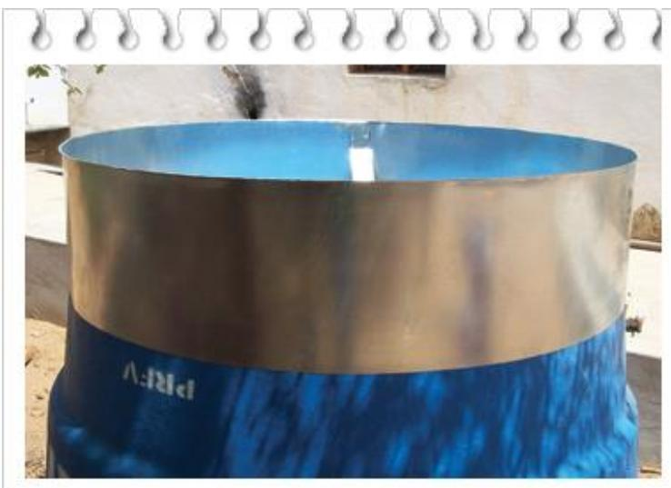
Deverá ser instalado um lastro de zinco de 5,81m de comprimento por 40cm de altura no fundo da caixa d'água. Preencha com areia ou terra como contrapeso para aumentar a pressão do biodigestor que fará com que o biogás chegue com mais força ao destino. Deve ser feita essa etapa
