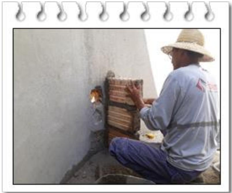
da estrutura, foi construído quatro batentes no fundo do Tanque, distribuído com distância proporcional um do outro, para cada batente foi utilizado 03 tijolos cerâmico furado 08 furos assentados um sobre o outro,
