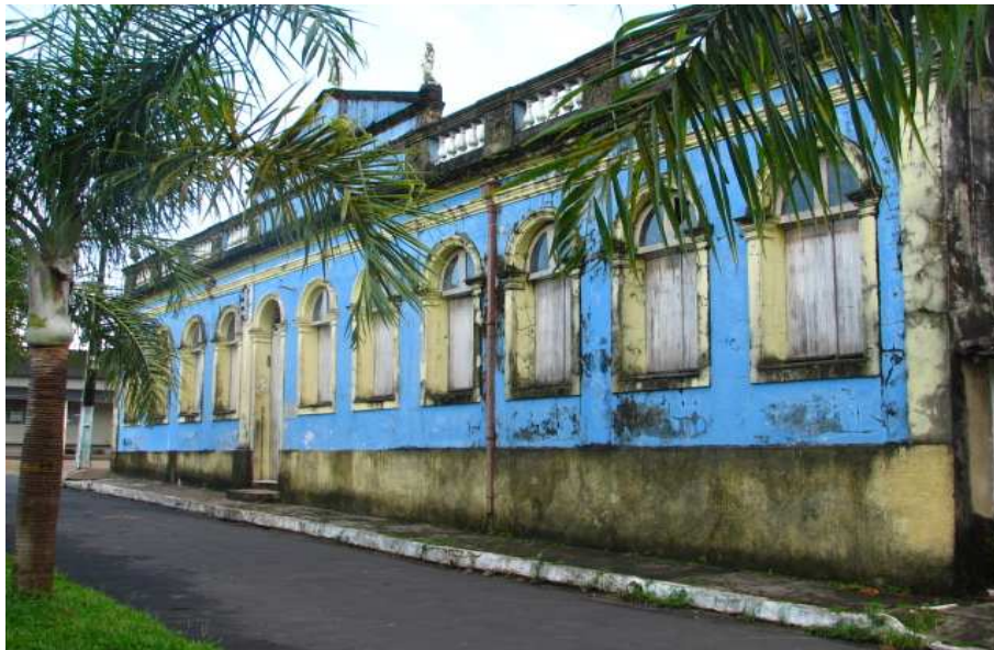
Antiga Construção – Curuçá
