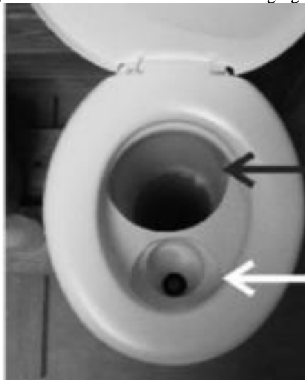
Figura 18: Banheiro Seco com Vaso Segregador.
