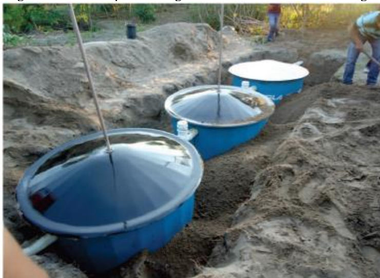
Figura 16: Fossa Séptica Biodigestora instalada na Amazônia Legal.
