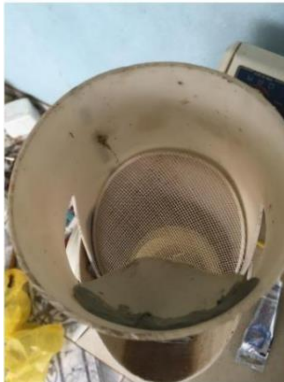
Figura 37 - Exemplo de instalação do crivo de retenção de sólidos grosseiros.
