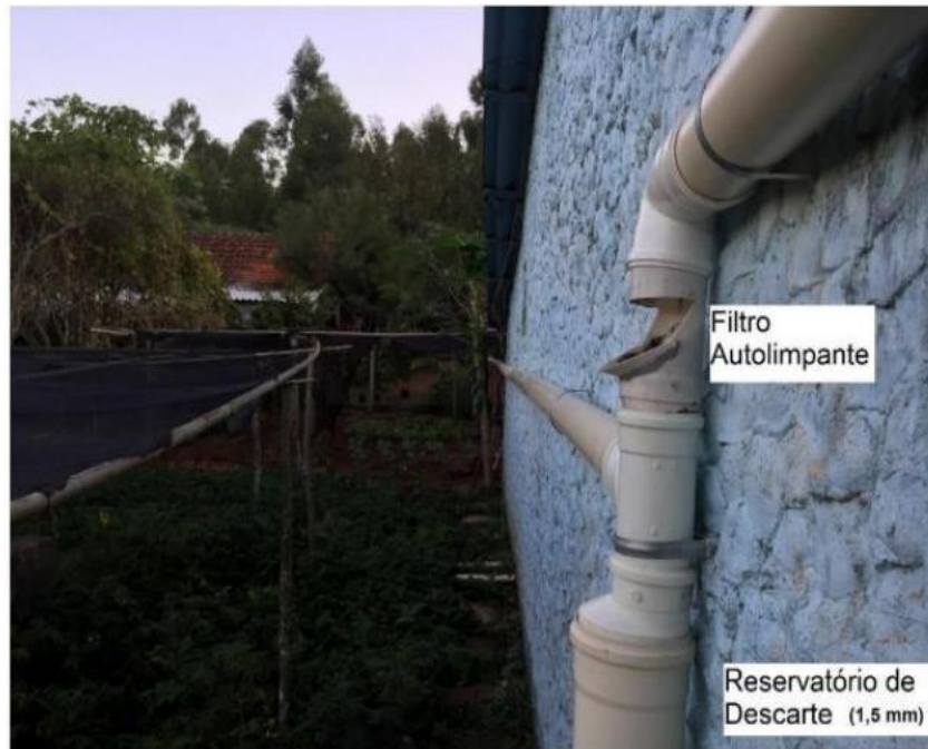
Figura 38 - Esquema da estrutura fixação de filtro autolimpante.
