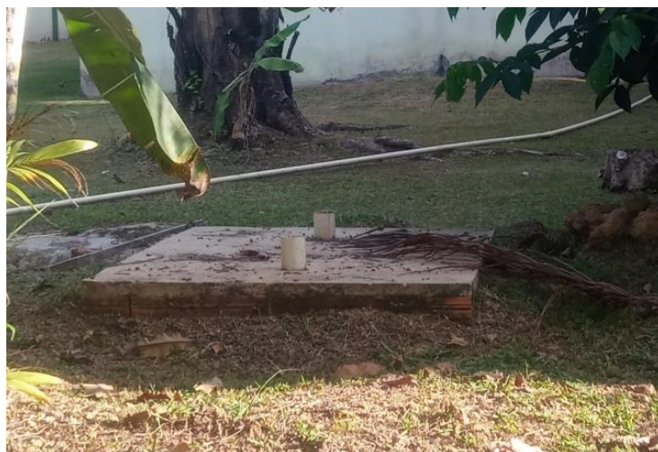
Figura 28: Tanque séptico na comunidade.
