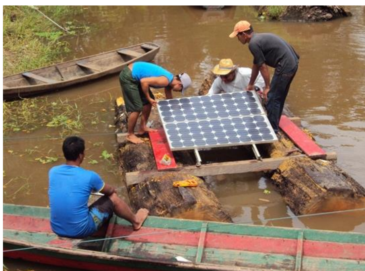
Figura 10: Sistema de bombeamento alimentado por energia fotovoltaica.
