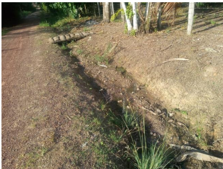
Figura 1: Valas para drenagem em uma comunidade rural.
