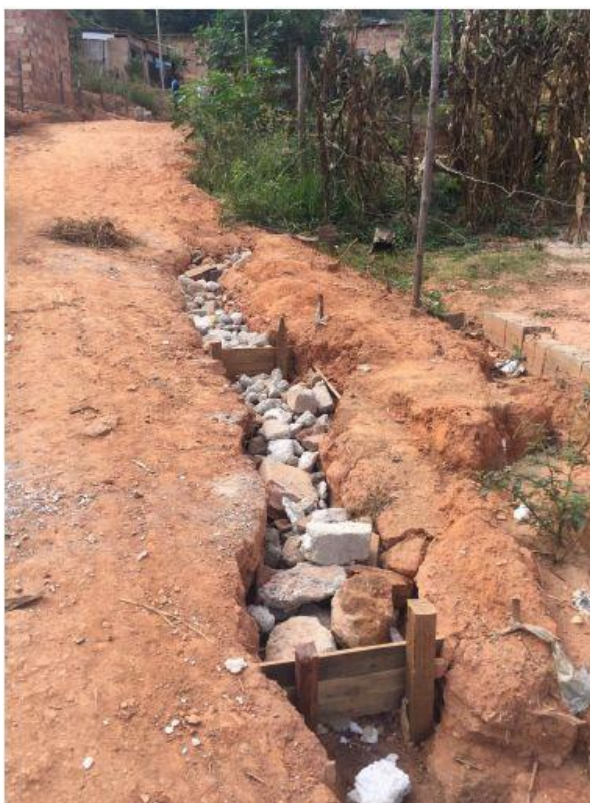
Figura 13: Vala de infiltração com entulho.
